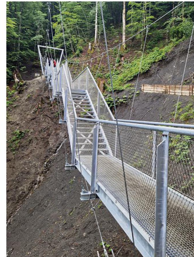
In luftiger Höhe schwebt die neue Hängebrücke über dem Südpfortal der Partnachklamm. SCHWANINGER (2)
